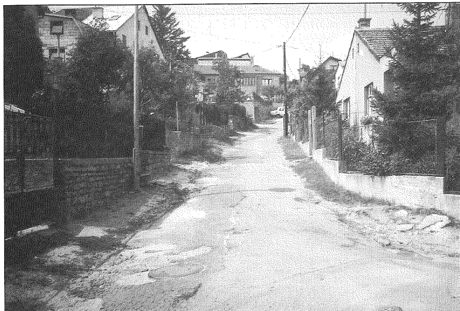
Žebětín před rekonstrukcí - srpen 1994
