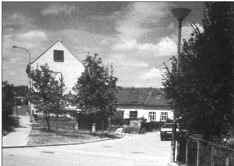
Práce IS Brno - ulice Obůrky
