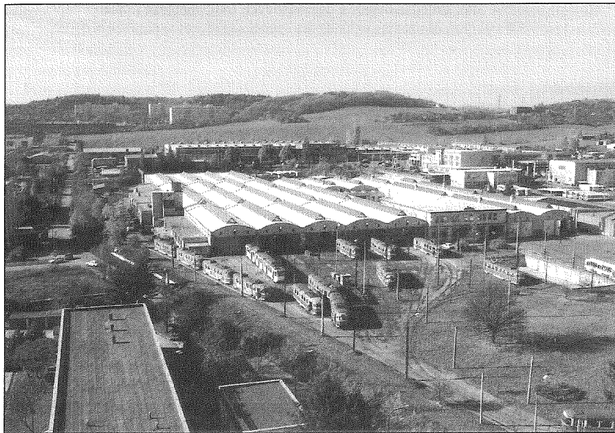
Pohled na část vozovny DPMB v Medlánkách
