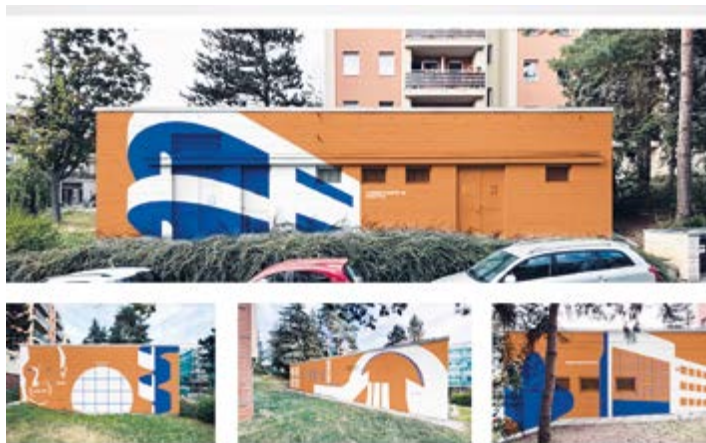
Vítězný návrh grafiky Petra Fajkoše pro trafostanici na ulici Višňová
